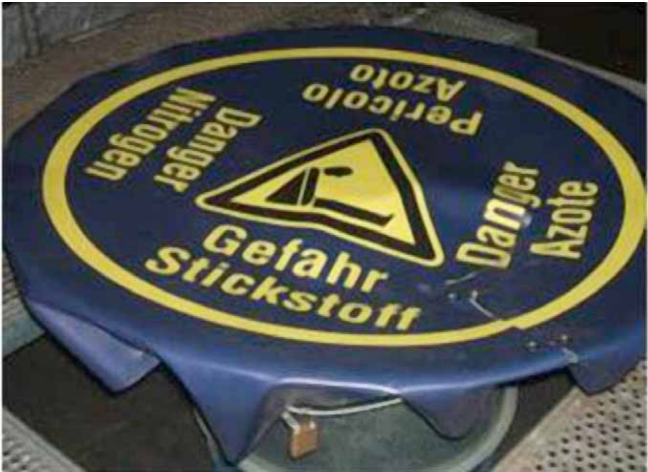
Kuva 2. Esimerkki miesluukun kannesta, jota voidaan käyttää kun huoltotöissä on pidempi tauko.
