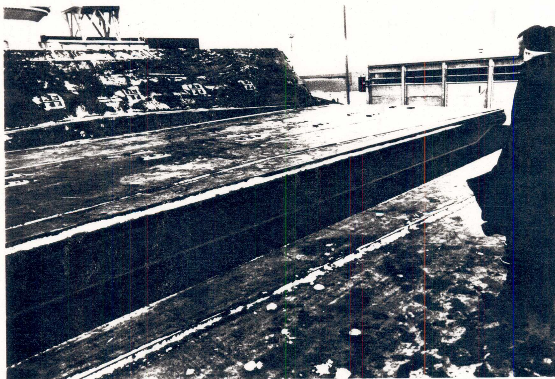
Kuva 4. Luukku 4 avautumassa. Miehet paikassa, jossa nostolaite oli.
