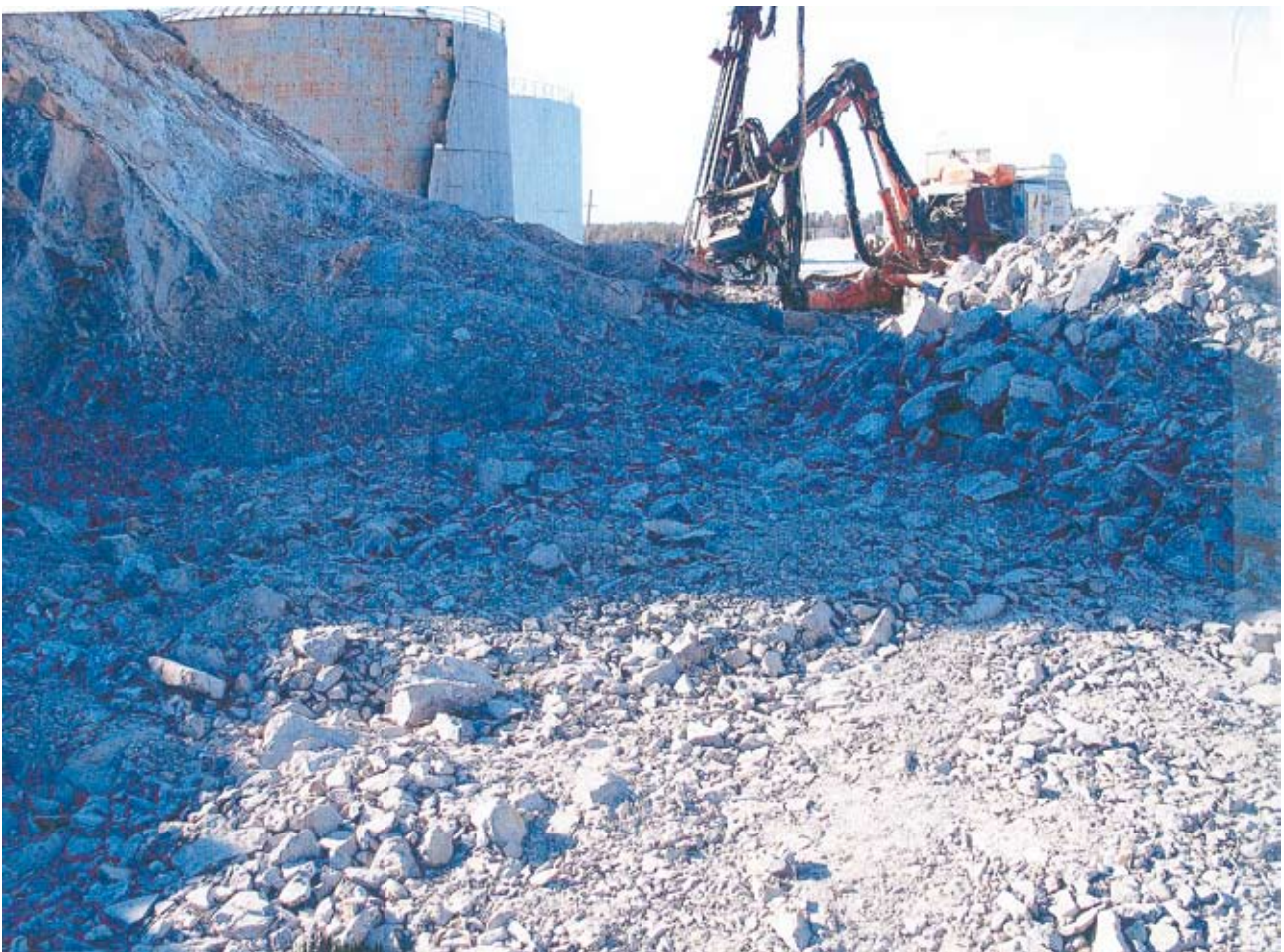
Kuva 1. Louhintatyömaa. Kenttä, jossa poraus- ja panostustöitä tehtiin.
